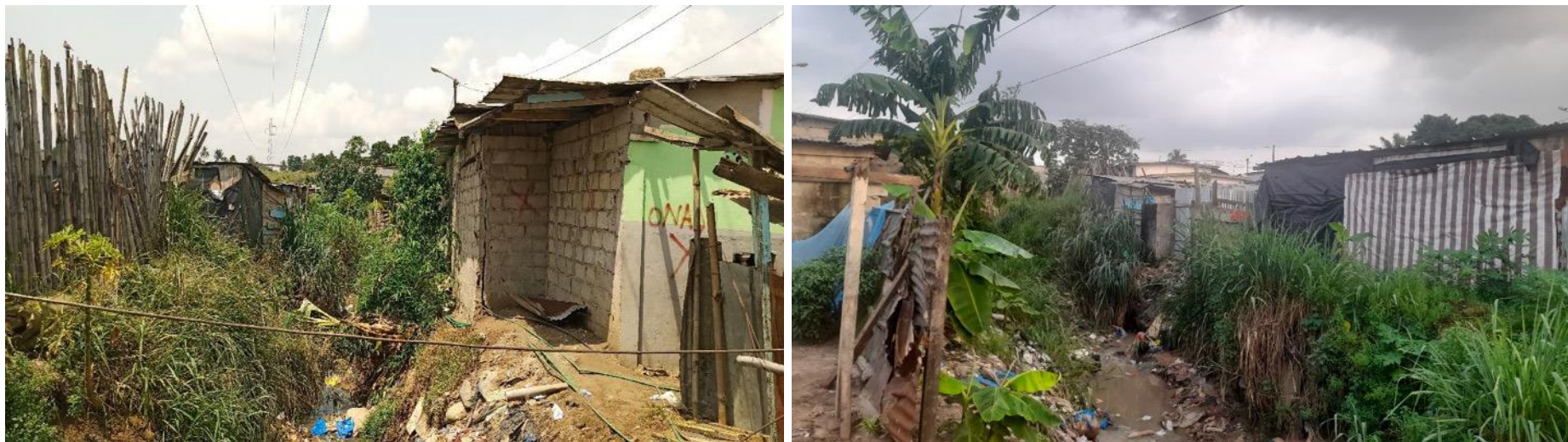
Planche 1 : Vues de l'état actuel du site de construction du canal C3-1
