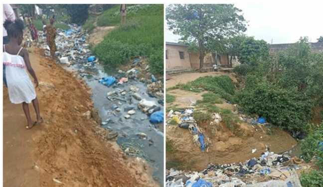
Photo 2 : Canal en terre non aménagé
